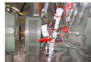
空気抜弁・配管 A)
