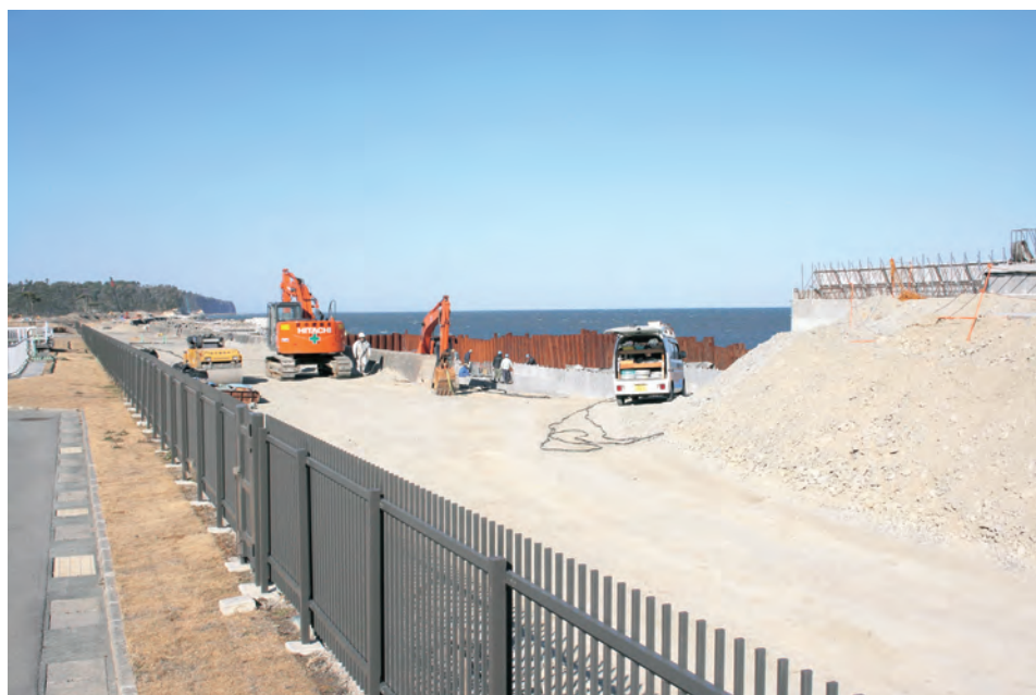
防潮堤（高さ 8.7m）の整備状況
