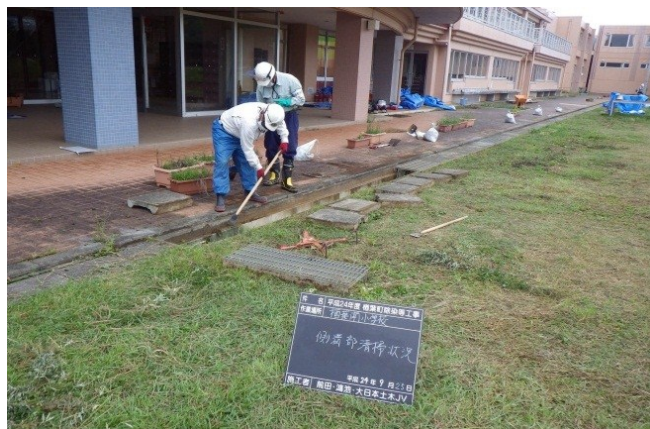
側溝清掃の様子
