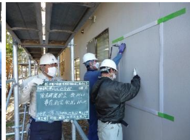
壁の確認調査の様子
