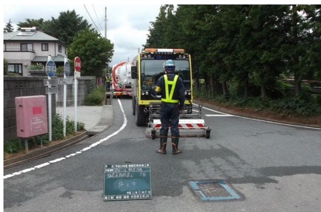
高圧水洗浄の様子
