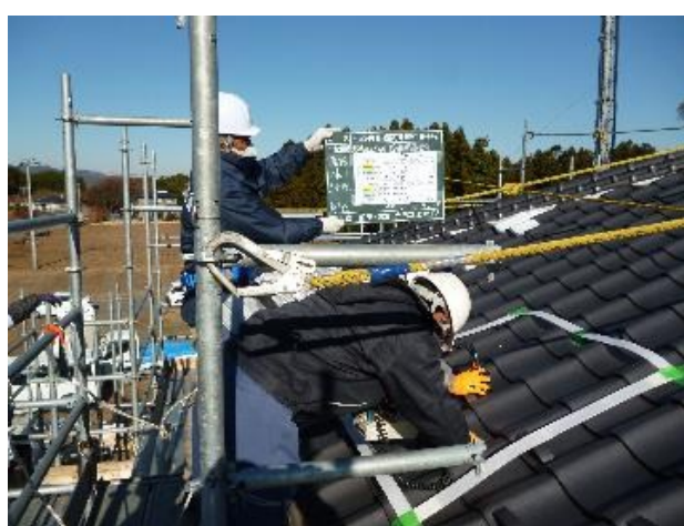
屋根の確認調査の様子
