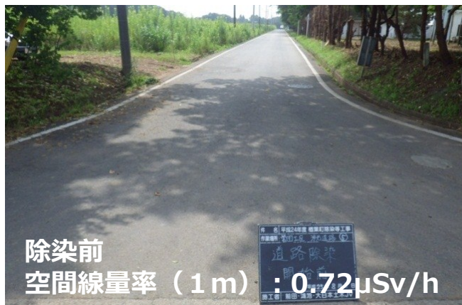
除染前の様子
