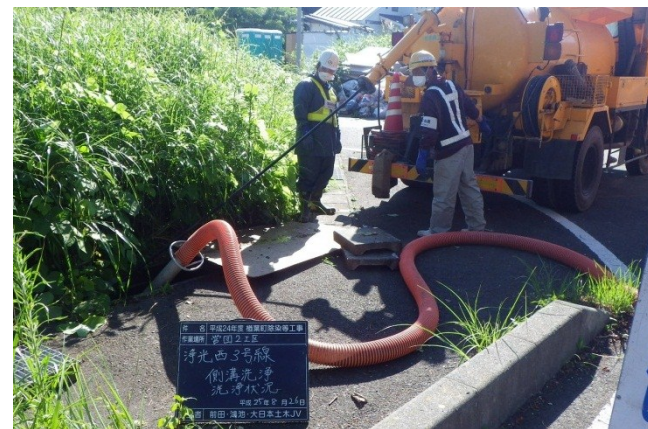
側溝洗浄の様子
