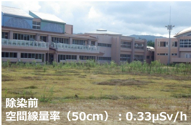
除染前の様子
