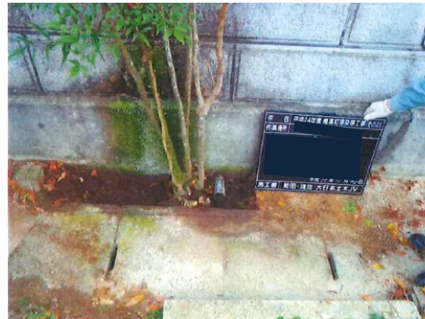
2. 土壌剥ぎ取り
