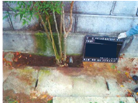
2. 土壌剥ぎ取り
