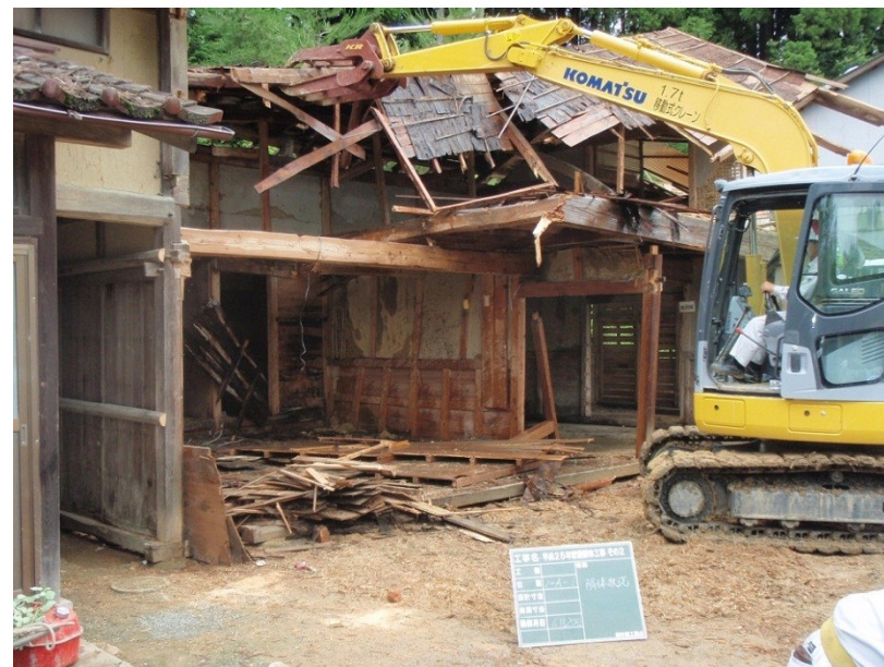
解体工事の様子（南相馬市の例）
