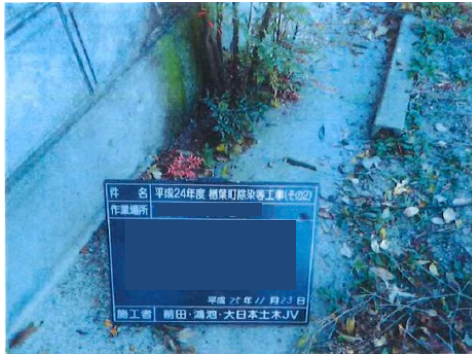
1. 施工前の様子
