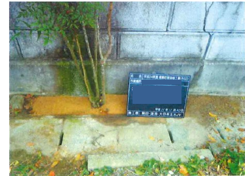
3. 施工後の様子
