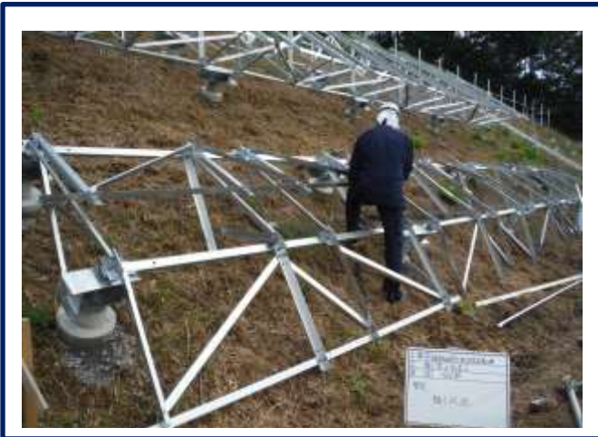
○架台設置工事
