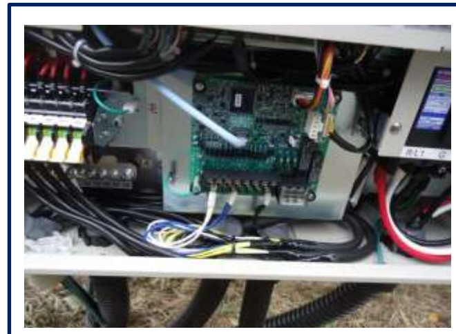
○電気設備工事
