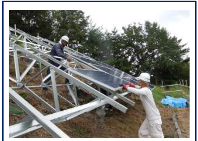
○太陽光パネル設置工事
