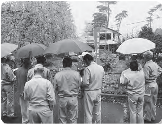
解体現場を視察
