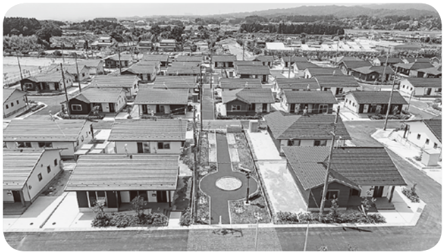
太陽光発電を導入する災害公営住宅
