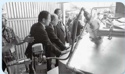
▲稼働中の溶融炉を視察
