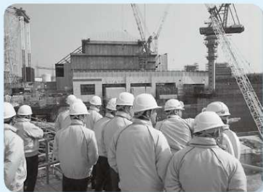
▲MOX燃料原子力発電所建設現場の視察
