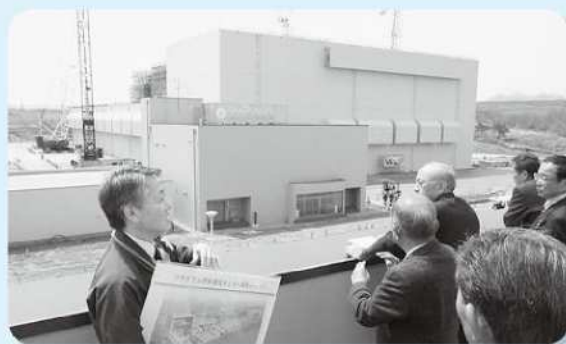
▲建設中のリサイクル貯蔵施設を確認
