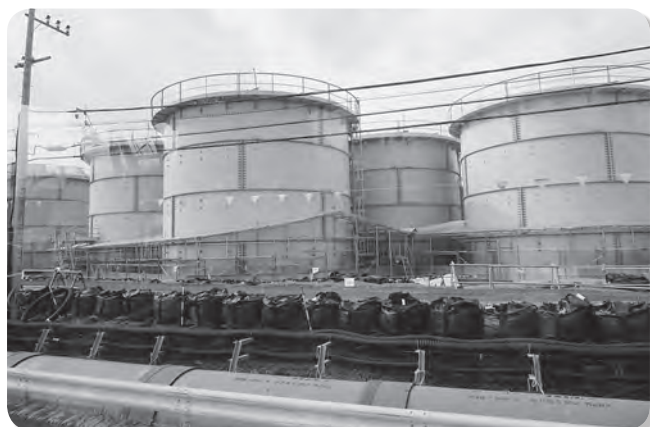
第一原発内の汚染水貯蔵タンク
