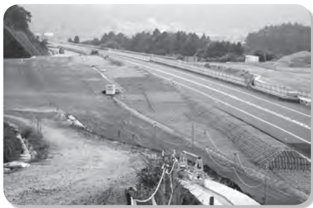
スマートインター建設現場
