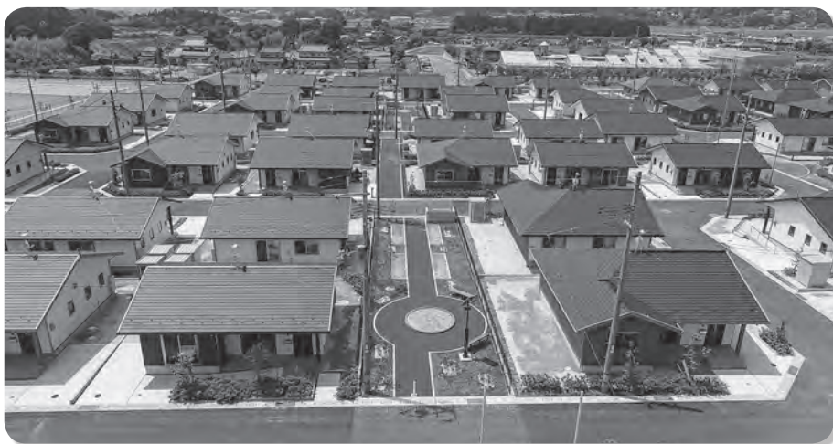
完成した災害公営住宅（北田中満地区）
