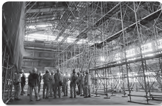
体育館内を視察
