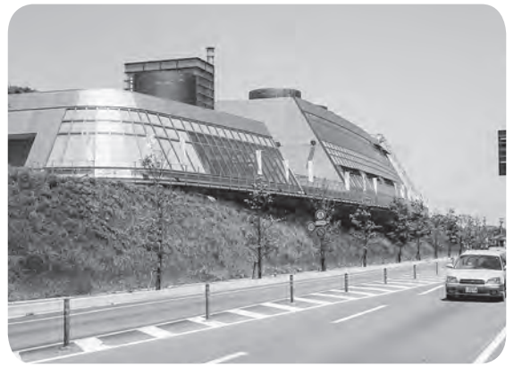
災害復旧工事が始まる道の駅ならば
