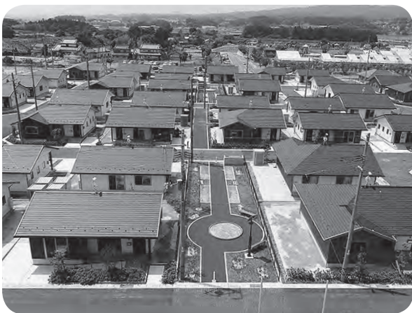
完成した災害公営住宅（中満地区）
