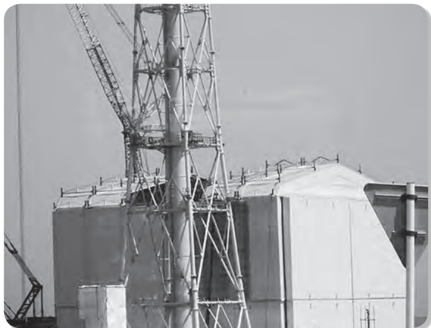
1号機建屋カバー撤去状況
