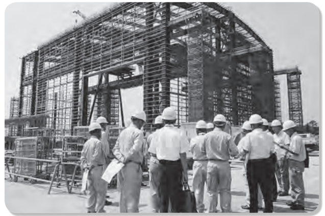
試験棟施工の様子
