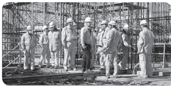
中学校建設現場（北田）
