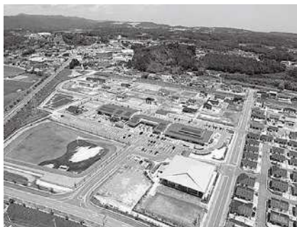
新たな宅地造成(北田地区)
